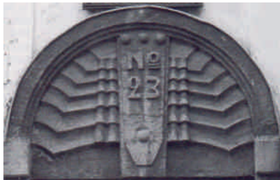
Фронтон бокового входа
